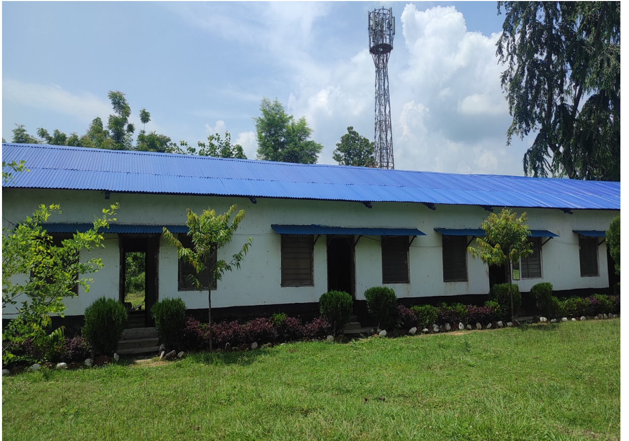
प्रहरी चौकी भवन मर्मत वडा नं. ९
